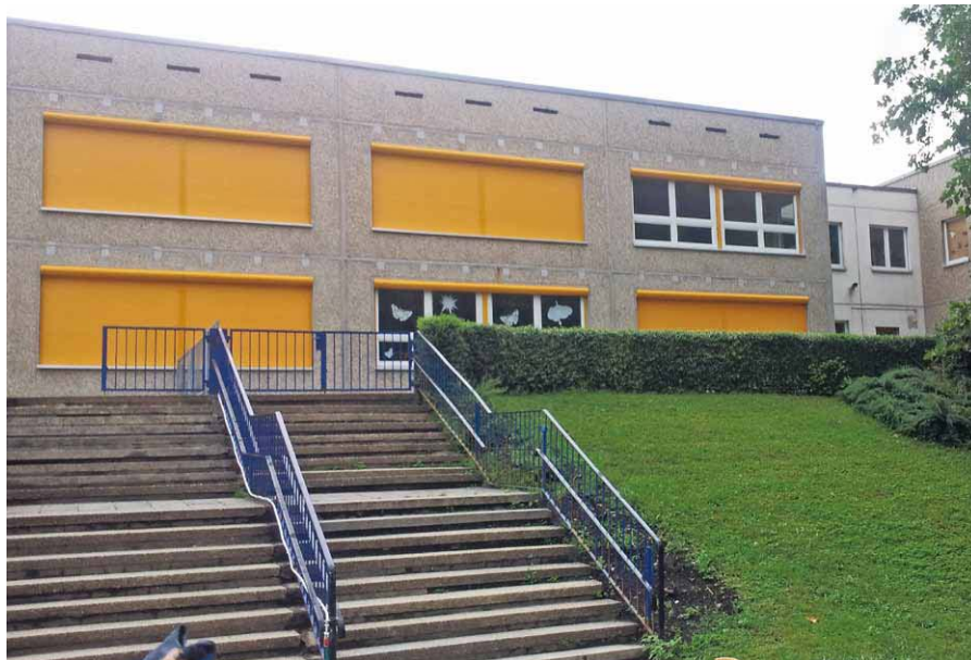
Die Kita in Zeitz wurde 2010 teuer saniert, soll aber 2015 bereits wieder schließen.
