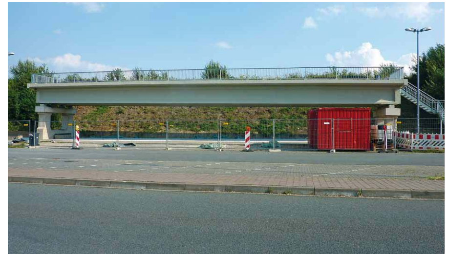
Da steht sie nun, die „Soda-Brücke“ am Autobahnrastplatz Vellern Süd.
